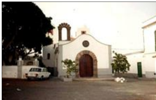
Firma de D. Marcos Peraza y Ayala. A la derecha, la iglesia de Arico el Nuevo.
