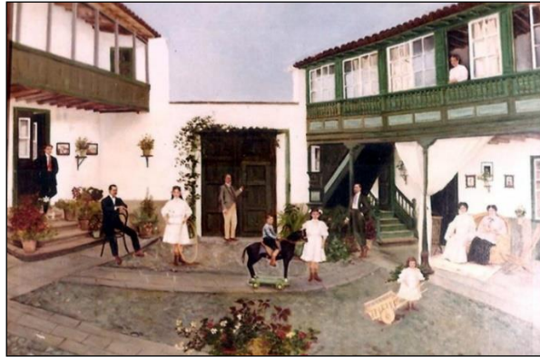
Casa de los Rodríguez de Azero en Arico el Nuevo.
